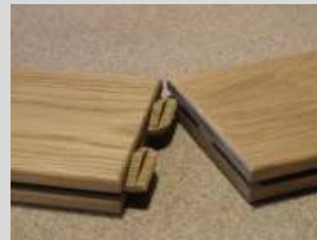
Wasserdurchlässige Schlitz- und Zapfenverbindung am Stoß mit **optimalen konstruktiven Holzschutz**. Die Stoßverbindung trägt sich alleine und soll nicht auf der Unterkonstruktion platziert werden, damit durchfallender Schmutz und Wasser nicht auf der Unterkonstruktion liegen bleibt.
